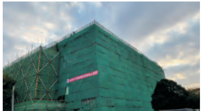
南山新建综合楼建设工地
