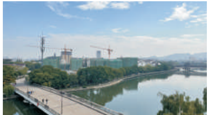
国际教育组团建设工地
