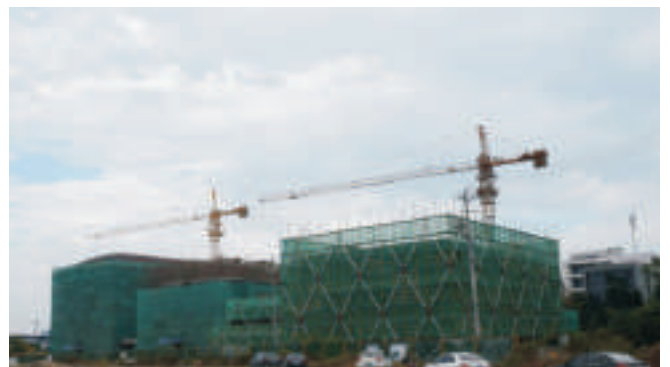
生科组团建设工地
